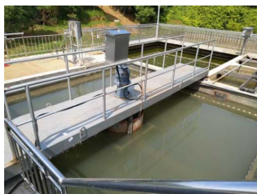
▲ 污水处理扩建项目
